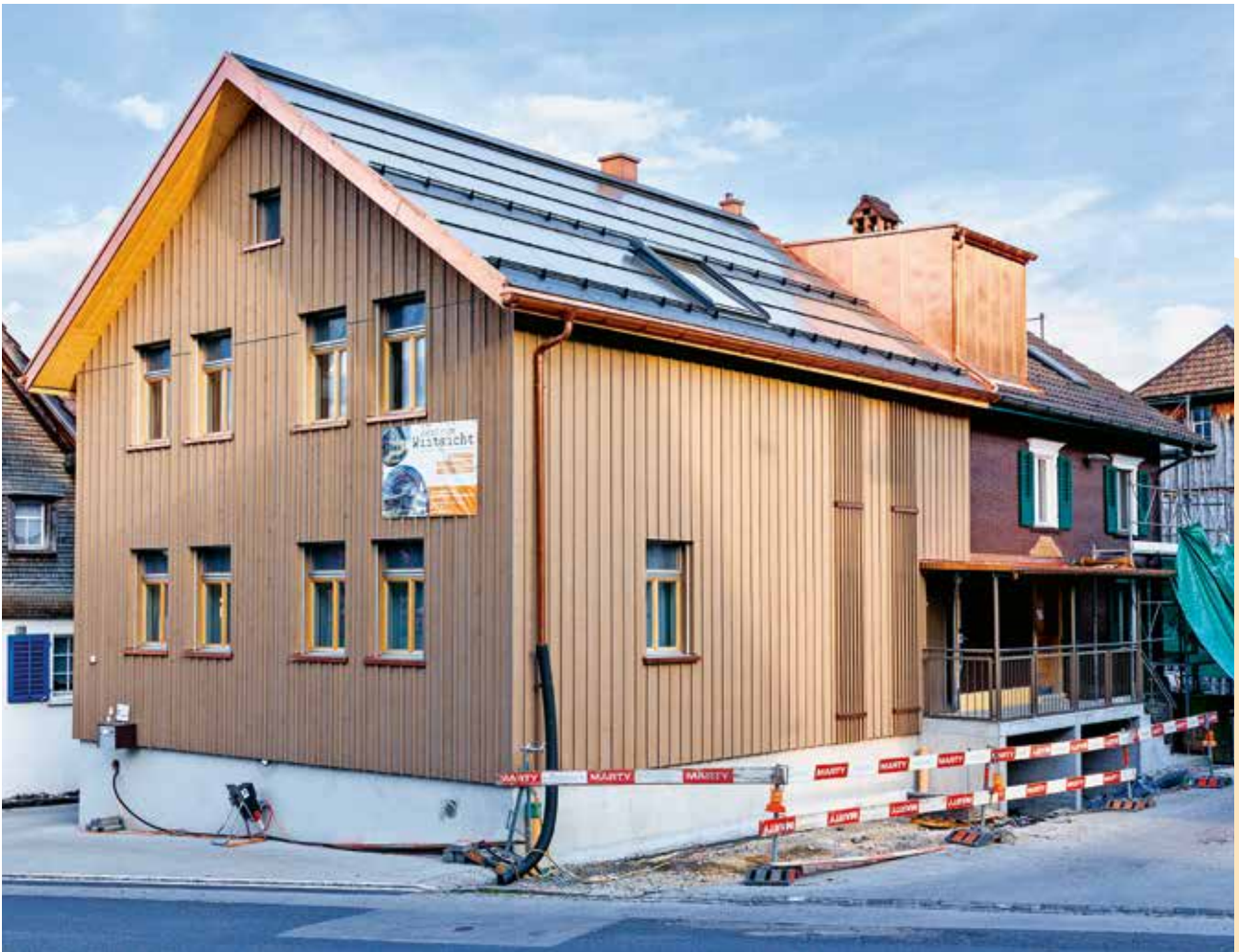
Neuer Anbau Tagesstätte
