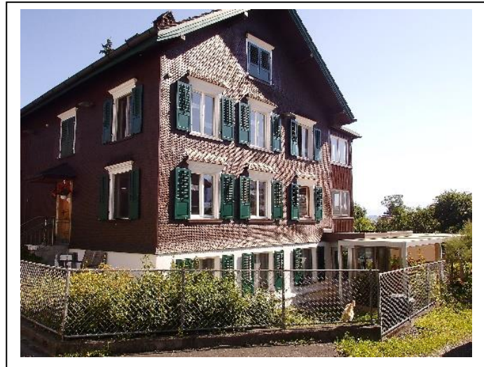
Tagesstättengebäude, das bestehen bleibt
